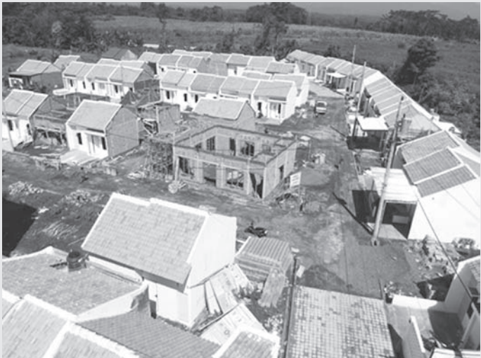
图示：中爪省巴唐县Griya Khalisa 2 Housing 补贴住房建设项目的航拍照片。
