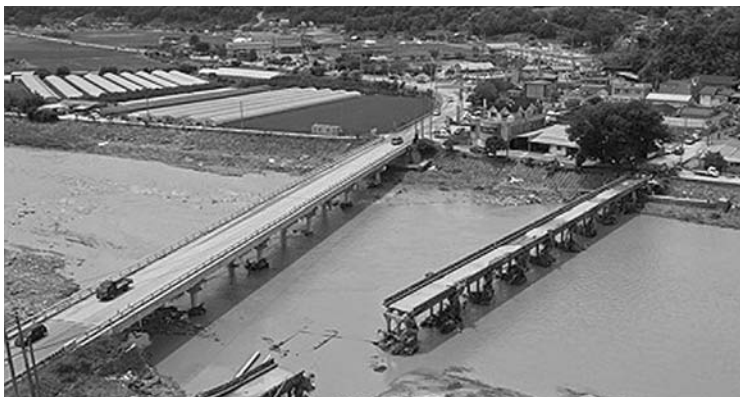
7月20日，在庆尚南道山清郡，桥梁被暴雨冲毁。(韩联社)
