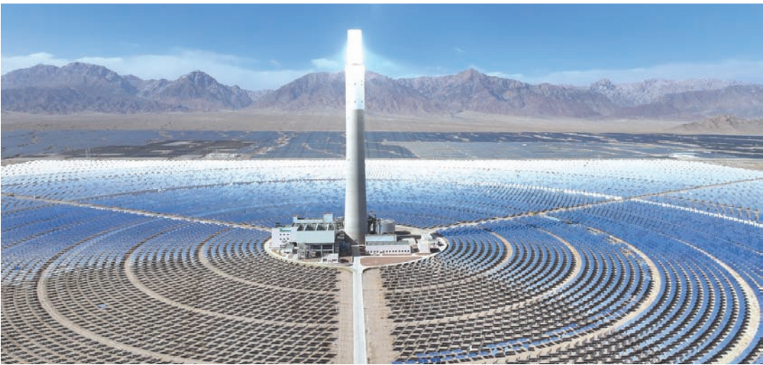
4月15日，位于青海省海西蒙古族藏族自治州德令哈市境内的青海中控50兆瓦光热电站。（无人机照片） 马铭言 摄
