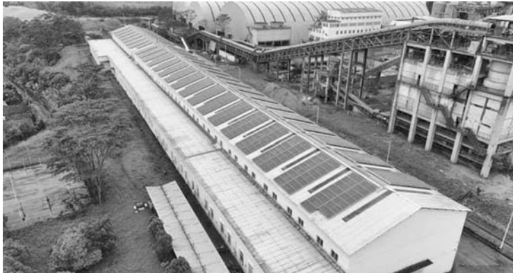
Indo Tambangraya Megah (ITMG) 公司旗下 Cahaya Power Indonesia (CPI) 公司的屋顶太阳能发电板 (PLTS)。
