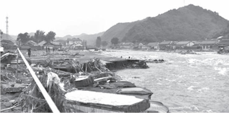
7月28日，河北省承德市滦平县马营子满族乡南台子西沟村因强降雨导致山体滑坡。当日18时许，中新社记者沿通往马营子满族乡方向徒步探访。目前，道路、电力、通讯等抢修正在有序进行。图为被冲毁的道路。
