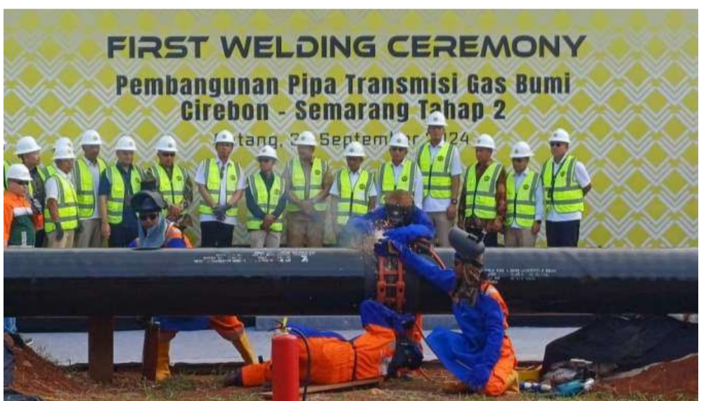
井里汶-三宝垄燃气管道建设项目(Cisem II)二期工程。
