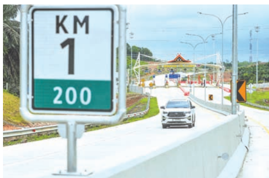
2025年9月11日，工作人员车辆穿行于穆阿拉占碑省贝通-坦皮诺-占碑第四段1公里处的跨苏门答腊高速公路闸口。印尼国有建筑公司Hutama Karya已获得公共工程部颁发的五星级功能与运营合格证书，标志着这条18.49公里长的高速公路已具备运营条件。
