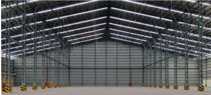
CKB Logistics公司在三马林达物流枢纽设施仓库的屋顶安装太阳能发电板(PLTS)。
