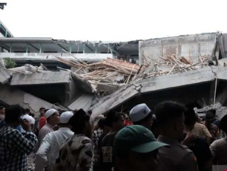
东爪哇省西图利祖AI Khoziny伊斯兰习经院一栋三层楼建筑坍塌后的现场情况。
