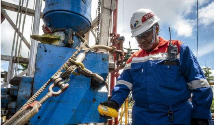
北塔米纳EP (Pertamina EP) 公司巴布亚油田的工人在西南巴布亚省索龙县克拉萨菲特区布阿米拉 (BMR) —001 勘探井钻探区监督钻井蒸汽测试 (DST) 活动。
