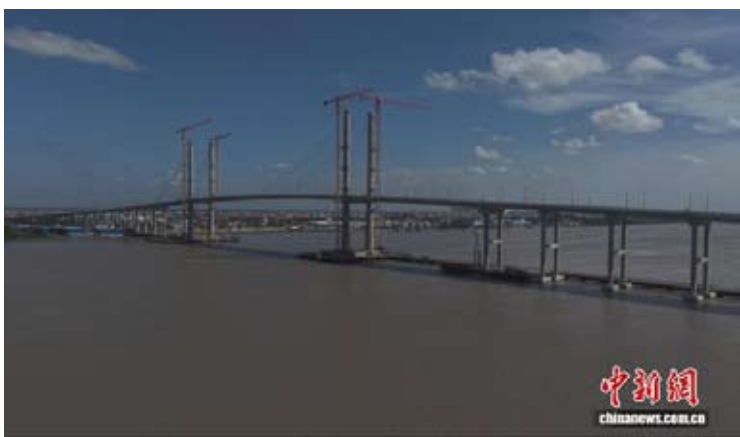
当地时间10月5日晚，圭亚那新德梅拉拉河大桥正式通车。（中国铁建国际集团有限公司供图）
