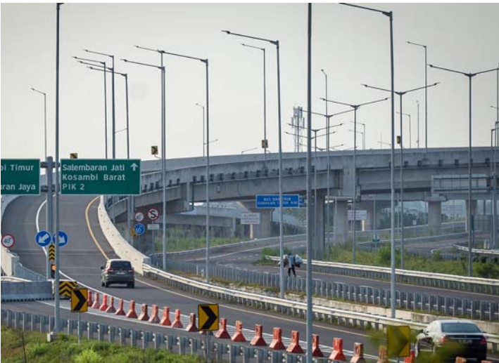
位于万丹省丹格朗县Kosambi镇区的Kamal—Teluknaga—Rajeg高速公路路段。
