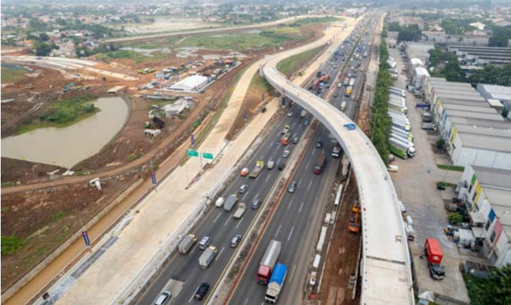
Paramount Petals 住宅区的直接高速公路是该住宅项目的基础设施发展重点之一，该项目于2024年7月开始建设。
