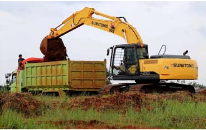
西瓜哇省茂物县，重型机械正在清理即将建设住宅区的土地。
