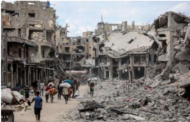
10月12日，在加沙地带南部汗尤尼斯，重返家园的巴勒斯坦人走过严重受损的建筑。新华社发（里泽克·阿卜杜勒贾瓦德摄）
