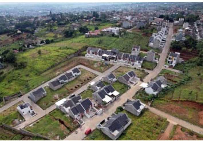
位于西爪哇省万隆县Cimenyan镇Cikadut村的住房建设项目。
