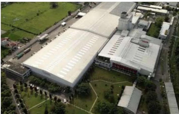
达能印尼 (Danone Indonesia) 公司在Prambanan工厂安装发电量达828千瓦的屋顶太阳能发电板。
