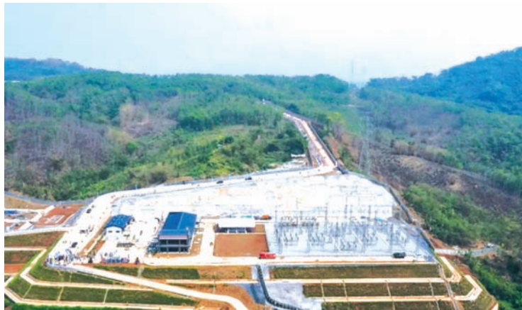
这张拍摄于2023年11月9日的航拍照片展示了印尼西爪哇省Cirata漂浮式太阳能发电厂的增压站。
