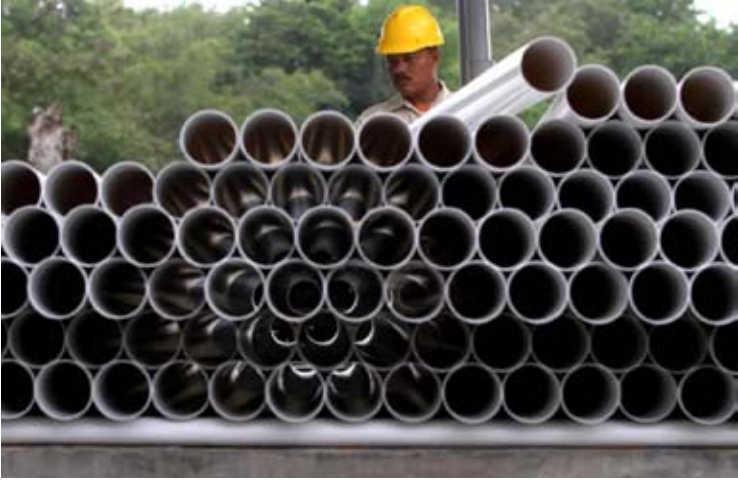
工人正在整理塑料管道情景。
