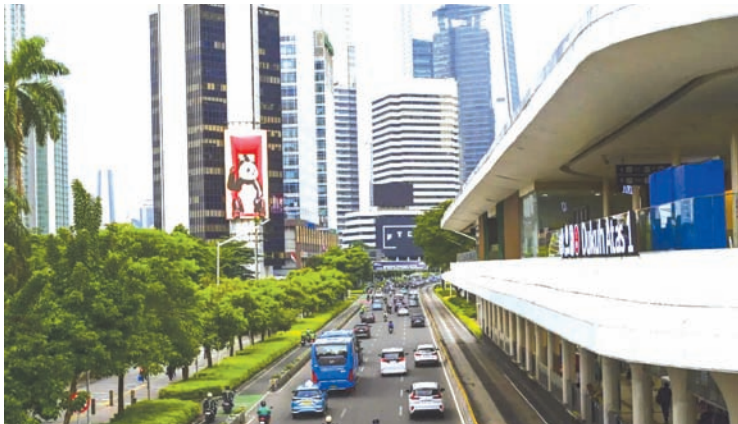
图为雅加达的一条主要公路工程。
