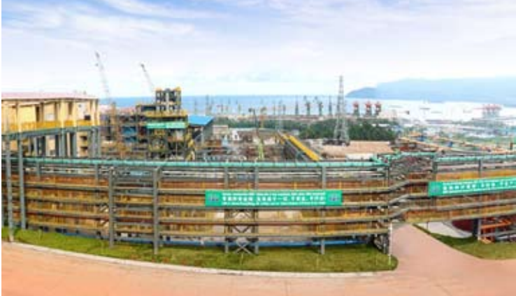
位于中苏拉威西省的印尼莫罗瓦利工业园区内的QMB New Energy Materials公司冶炼厂设施。
