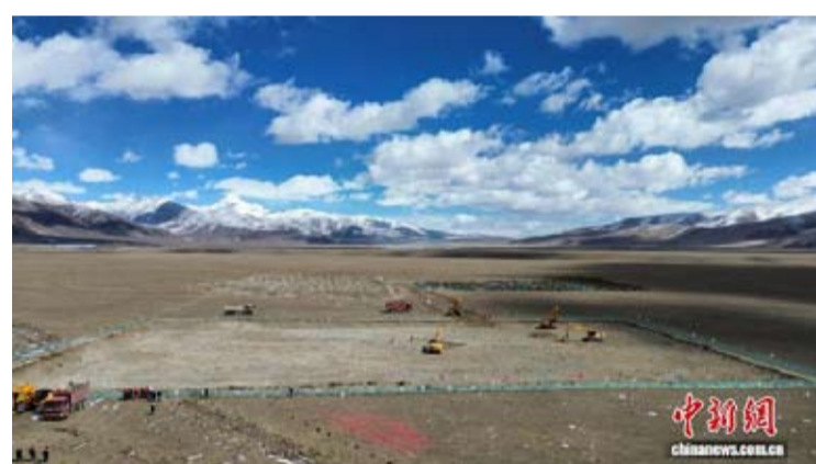
4月6日,全球海拔最高的槽式光热电站——中广核西藏乌玛塘50兆瓦光热项目在拉萨市当雄县乌玛塘乡正式开工建设,图为项目开工现场。(中国广核集团供图)
