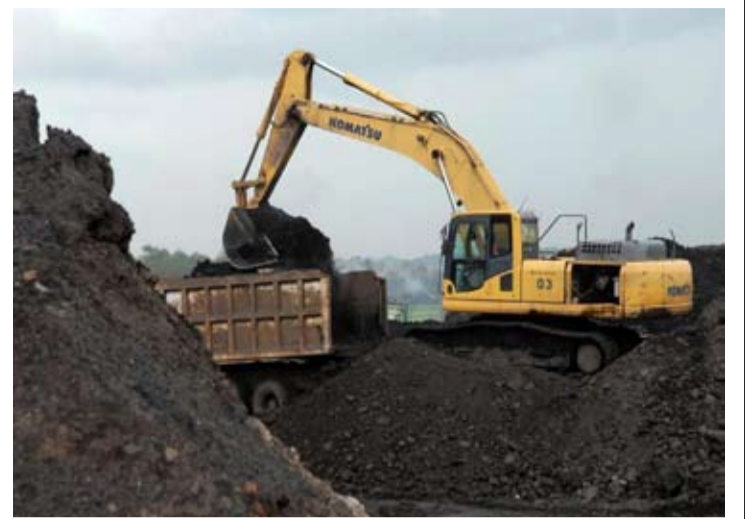
挖掘煤矿的重型机械。
