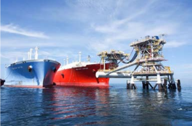
PGN LNG公司在楠榜浮式储存再气化装置 (FSRU)。
