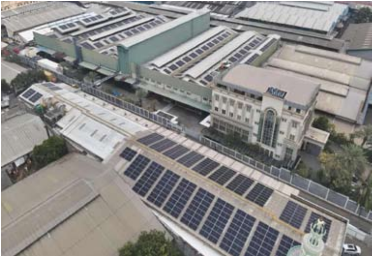
Garuda Metalindo 公司(BOLT)厂房。
