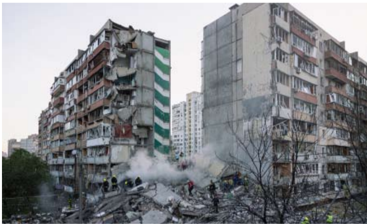
5月14日, 乌克兰紧急服务人员在在一栋部分倒塌建筑的废墟中搜救。
