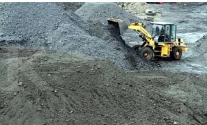
工人操作重型机械情景。
