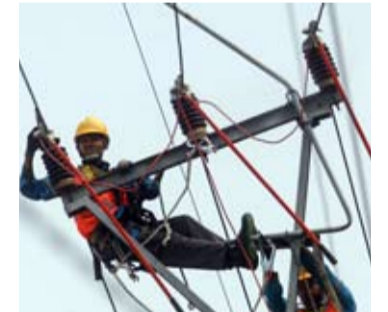
2026年6月4日, 在西爪省德波市茂物公路(Jalan Raya Bogor), 印尼国家电力公司(PLN)工作人员对输电线路进行检修维护。
