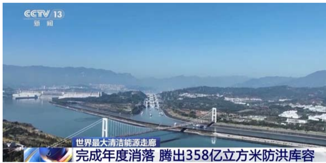
世界最大清洁能源走廊完成年度消落 腾出358亿立方米防洪库容
