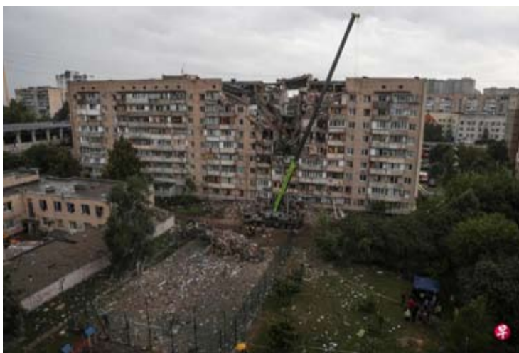
乌克兰首都基辅一栋公寓楼7月6日遭俄罗斯导弹和无人机袭击后, 楼体中间被炸出巨大黑洞。救援人员出动吊车清理瓦砾, 继续在受损现场搜救。(路透社)
