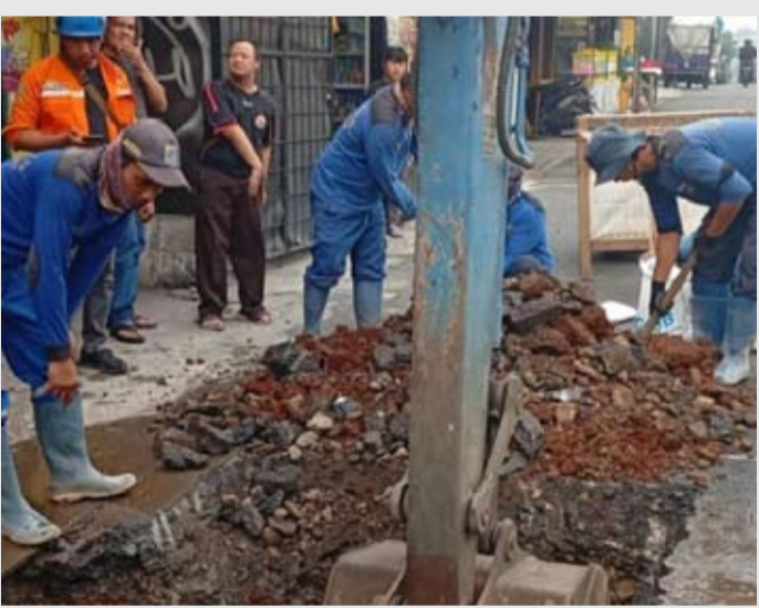
周二(7月7日), 雅加达西区水资源分局的工作人员正在Kebon Jeruk地区的Jalan Assirok路段修复一处塌陷坑。
