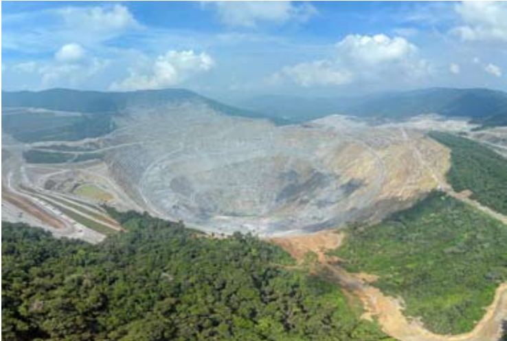
安曼矿业国际公司（AMMN）完成位于西努沙登加拉省西松巴哇县的铜冶炼厂项目建设。
