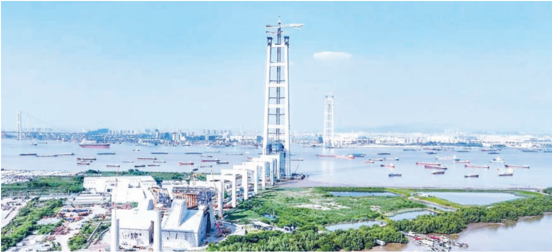
7月28日，广州南沙，狮子洋大桥已转入上部结构施工。张煜 摄
