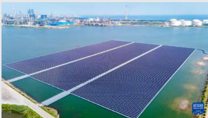
2025年7月4日拍摄的中国石化青岛炼化全海水环境漂浮式光伏项目现场（无人机照片）。
