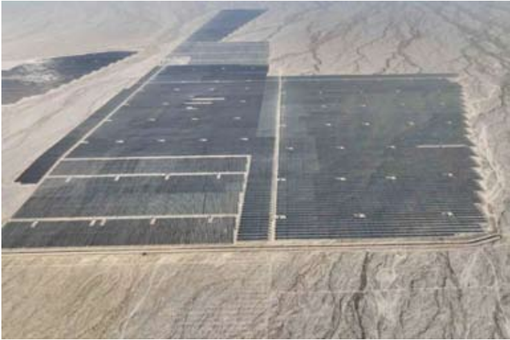
图为博湖县60万千瓦光伏项目现场
