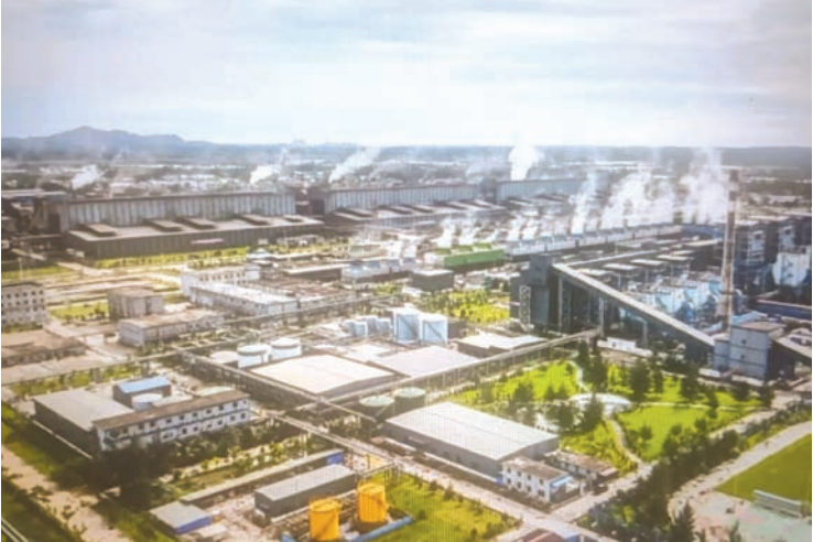
印尼德龙镍业有限公司完成两条大型焙烧矿生产线建设并正式投入运营。
