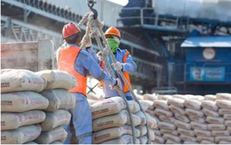
工人正在搬运水泥袋情景。
