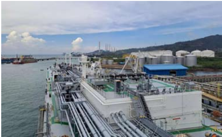
石化行业液化石油气 (LPG) 生产设施。
