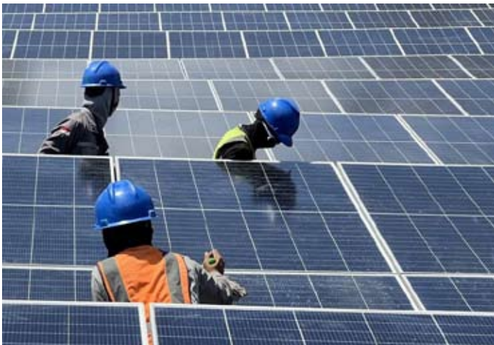
2026年8月25日，工作人员在印尼巴厘省吉利马努克清洁能源光伏电站的太阳能电池板。其中，6个总装机容量达4548.92MWp的项目已具备招标条件，分别是装机容量1688MWp的Jatiluhur漂浮式光伏发电项目、1250MWp的Cirata漂浮式光伏发电项目、636MWp的Jatigede漂浮式光伏发电项目、605MWp的马都拉光伏发电及电池储能系统（BESS）集群项目、300MWp的巴厘光伏发电项目，以及69MWp的Purwakarta国家土地银行用地光伏发电项目。马都拉和巴厘项目旨在减少燃油消耗。
