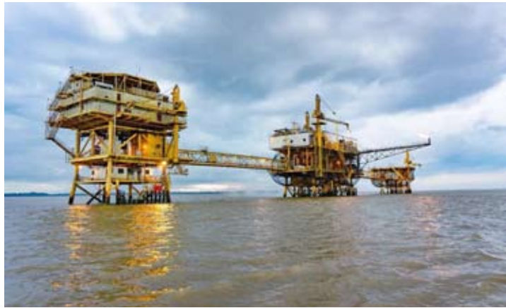
海底油气钻井设施。
