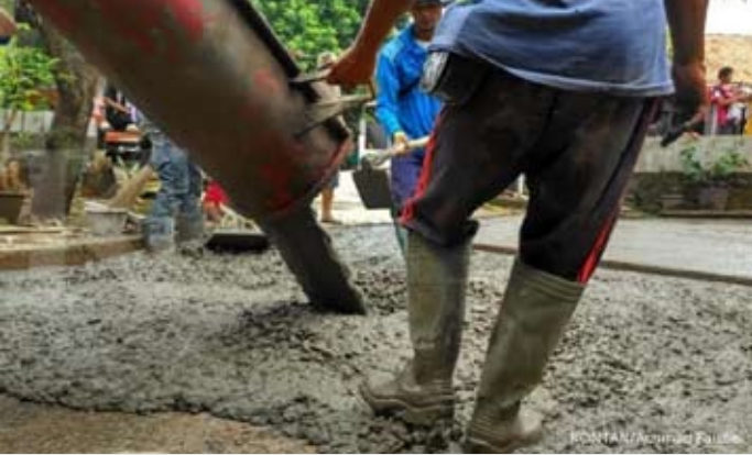
工人搅拌水泥情景。
