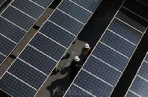
在雅加达能源与矿产资源部电力总局办公室, 工作人员正在检查太阳能电池板的状况。
