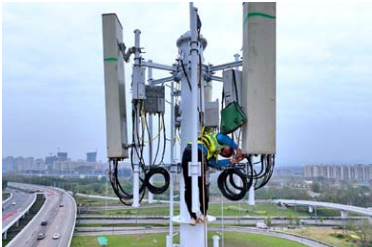
2022年12月10日，移动通信技术人员在江西省赣州蓉江新区赣南大道5G基站安装调试5G信号设备。
