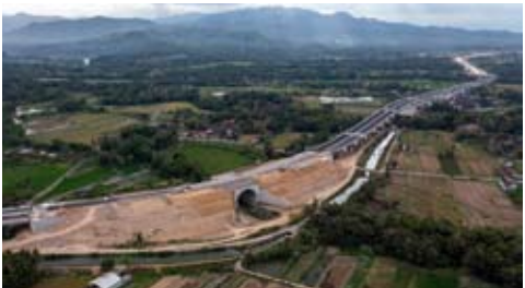
这是2026年8月27日在印尼日惹特区斯莱曼县塞耶甘 (Seyegan) 拍摄的日惹—巴文收费公路建设项目航拍画面。
