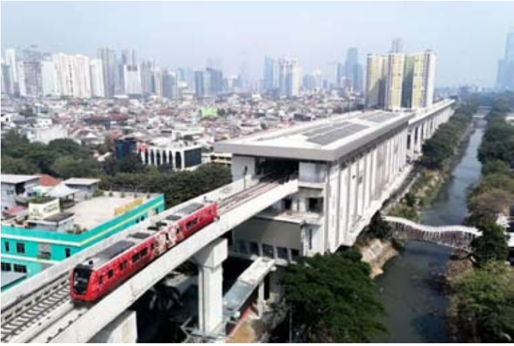
雅加达轻轨（LRT）1B阶段（Manggarai—Velodrome）线路服务于9月10日开始有限运营。
