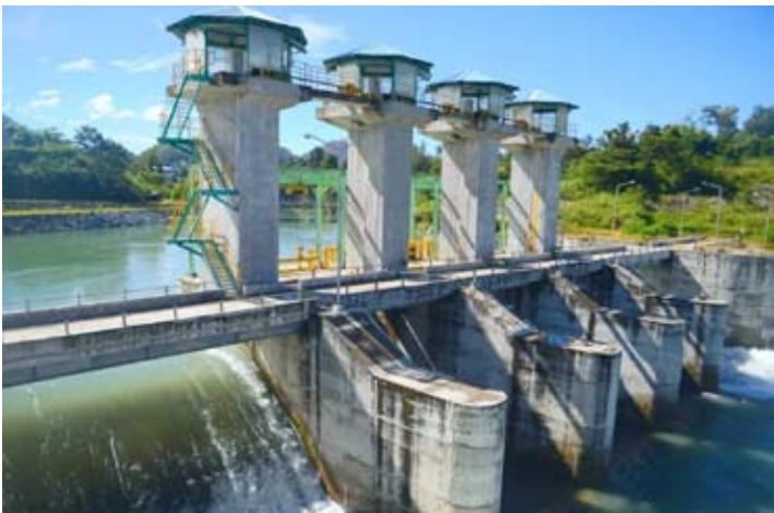
位于印尼中苏拉威西省波索县苏莱瓦纳村的波索水电站，装机容量为515兆瓦，由卡拉集团旗下波索能源公司运营。（波索能源公司供图）
