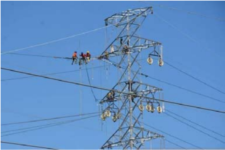
印尼国家电力公司输电设施。（资料照片）
