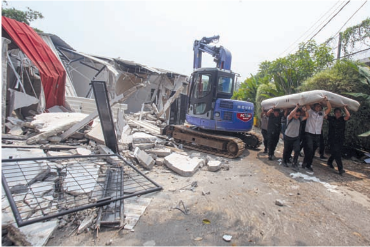
2026年9月30日，印尼移民与惩教部惩教总局局长马舒迪主持拆除了芝比农监狱内的10栋豪华公寓式设施。
