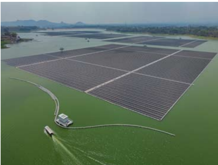
2026年9月29日，东爪哇省玛琅县卡朗卡特斯漂浮式光伏电站建设项目航拍图。
