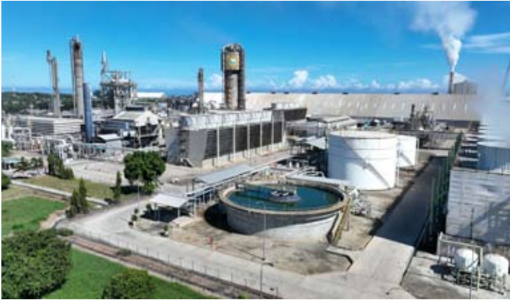
印尼东加里曼丹省邦唐市，印尼化肥公司（PT Pupuk Indonesia）旗下东加里曼丹化肥公司（PT Pupuk Kalimantan Timur，简称PKT）的化工及化肥厂区。（资料照片）
